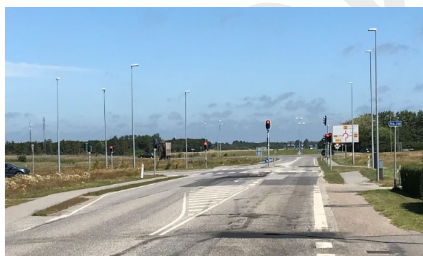
Den eksisterende lysregulering på Holstebrovej.
